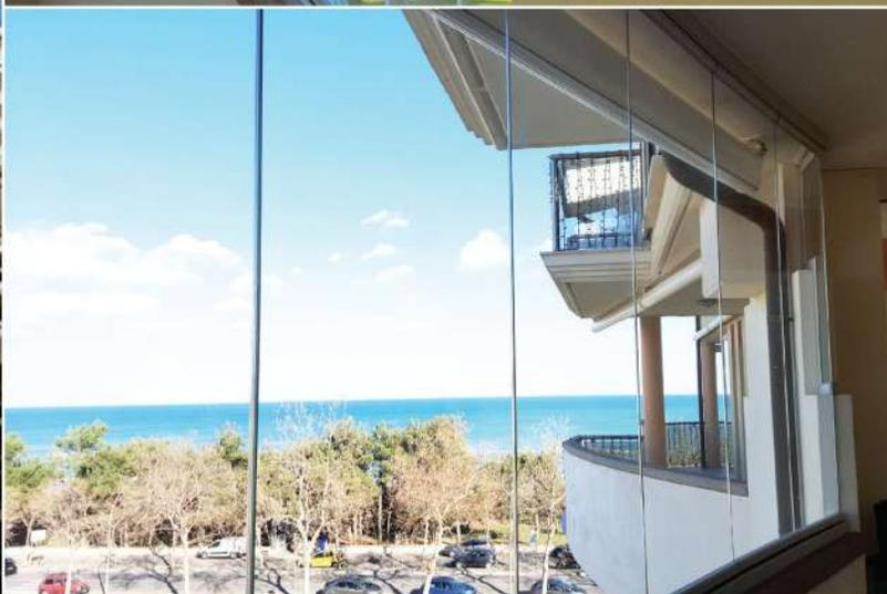
STAR GLASS 50 con guida inferiore è un sistema impacchettabile caratterizzato da fascioni in alluminio. L'assenza di montanti verticali permette di mantenere la visuale completamente libera.
